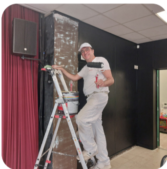
La rénovation des peintures du Bar'ouf est en marche !
